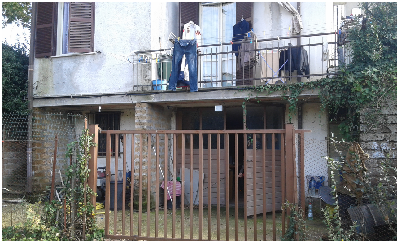
FOTO 4: Ingresso piano seminterrato
